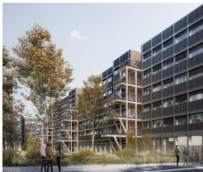
Figure 16 : Résidence étudiante Athena | Orsay (91) | BBC Effinergie 2017 | MO : Demathieu Bard Immobilier | Architectes : KOZ architectes
