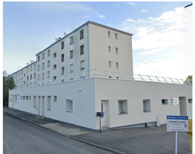
Figure 8 : Rénovation Basse Consommation Copropriétés Saint Sébastien sur Loire (44) [MO : Piveteau Immobilier]
