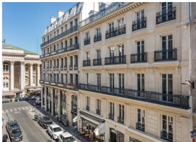
Figure 10 : Rénovation 22 rue de la Banque |Paris (75) | Basse Consommation| MO : SCI AG 22 rue de la Banque | Architecte : YMA
