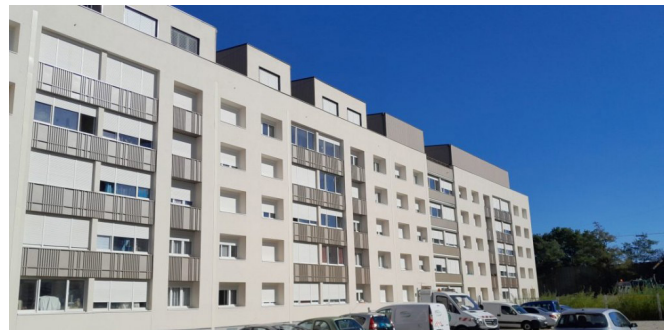
Figure 28 : Résidence Pranard | Bepos Effinergie 2013 – Villeurbanne | MO : Est Métropole Habitat | Architecte : Tekhné
