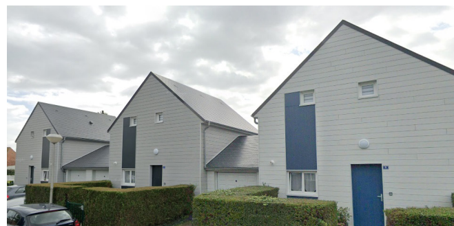
Figure 3 : Maison BBC | Cabourg (50) | Rénovation Basse Consommation | Dispositif : Rénovation Logement Social – FEDER Normandie
