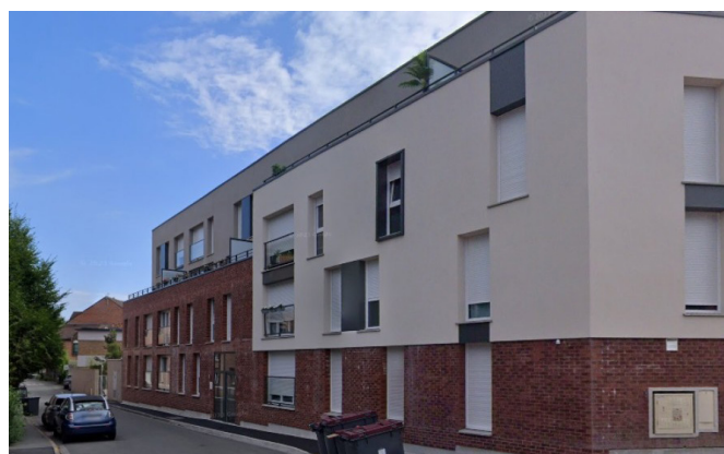
Figure 17 : Rue du Moulin | Marquette Les Lille (59) | Bepos Effinergie 2017 | Architecte : Cabinet Cochet Dehaene | MO : SIA Habitat
